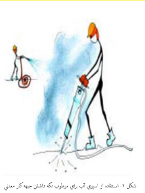
شکل ۱- استفاده از اسپری آب برای مرطوب نگه داشتن جبهه کار معدنی
